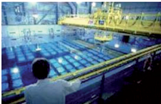
Figura 3: Piscinas de enfriamiento del combustible usado.
