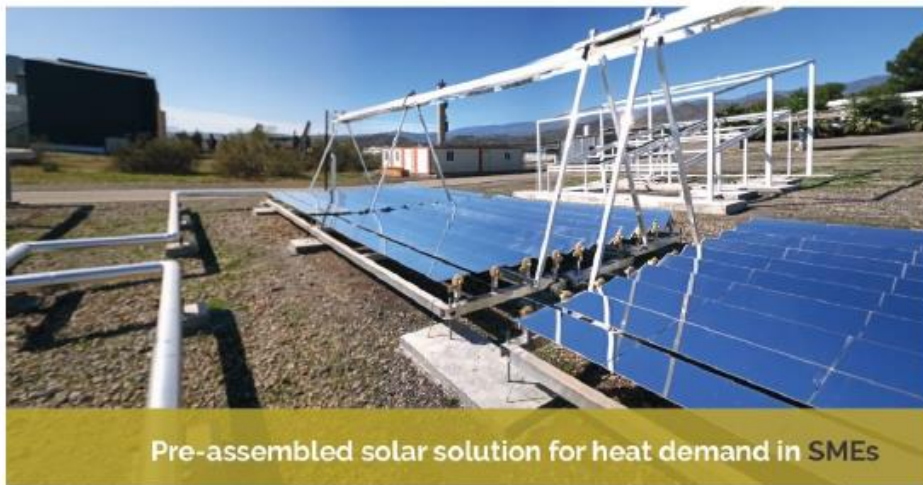
Fig. 7. Colectores Fresnel de SOLATOM escogidos.
