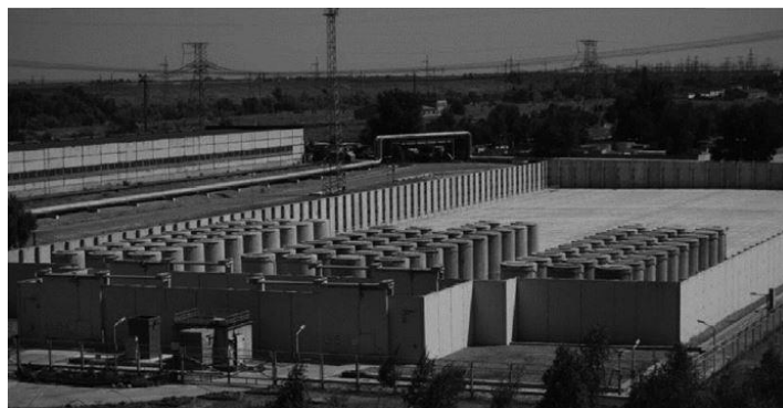
Figura 2-21: ATI Tipo losa 15
