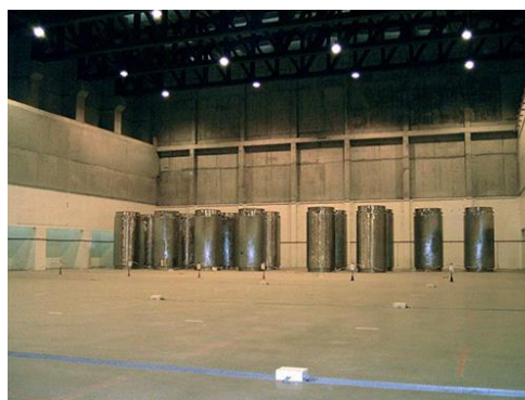
Figura 2-20: ATI Tipo edificio (Trillo)
